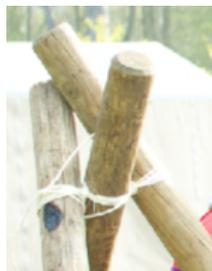
3. Relier les 2 trépieds en fixant 2 perches horizontalement à environ 75 cm du sol avec des brelages.
